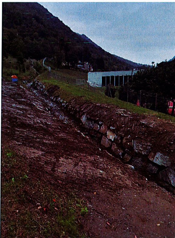
Foto no. 2 – Sistemazione argine
