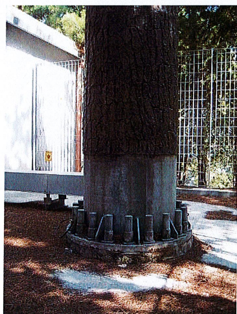
Mascheramento di antenna / Fonti: www.ibes.ch ; www.silbernagl.biz/Mobilfunk/Standorte.php ;
