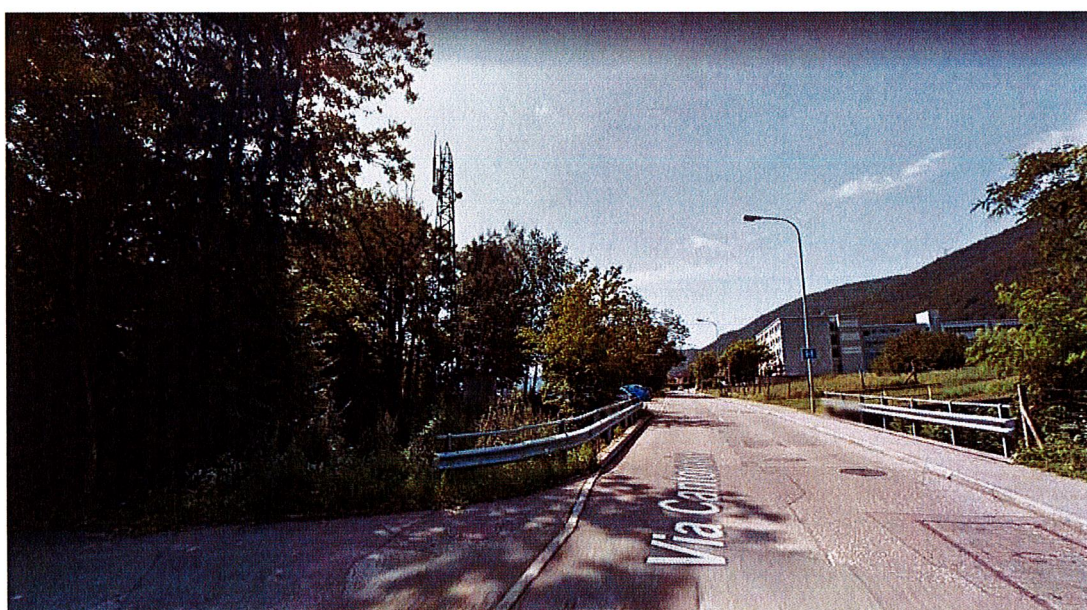
Antenna 4G esistente presso via Cantonale in zona forestale (fmn 685); con l'attuale pianificazione rientra nel raggio d'esclusione dell'EP 5 - Casa anziani (Street view 2014)
